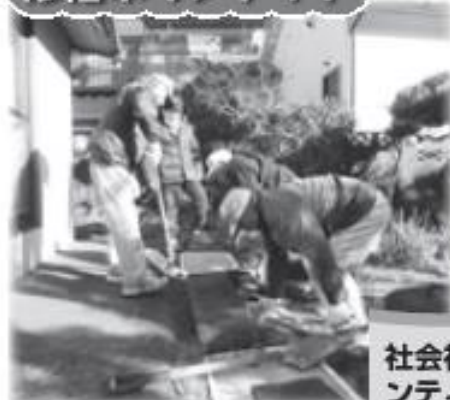
1/16 足場の改修作業の様子
