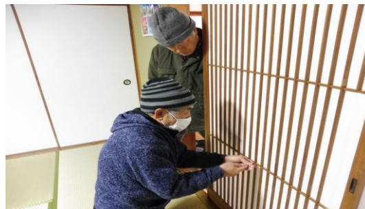
(修繕ボランティア)
