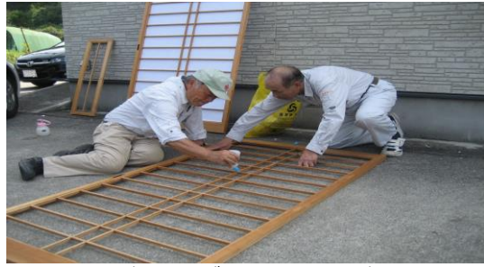
(修繕ボランティア)
