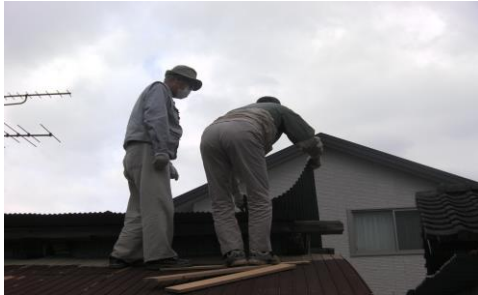
（修繕ボランティアによるトタンの張替え作業）
